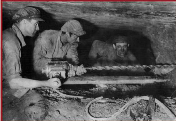
Механизация Донбасса. Электросверлильная машина за работой на Рутченковском руднике. Донбасс, 1929 г.
