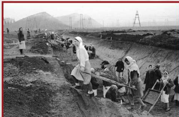
Строительство противотанковых рвов в районе Донбасса.
